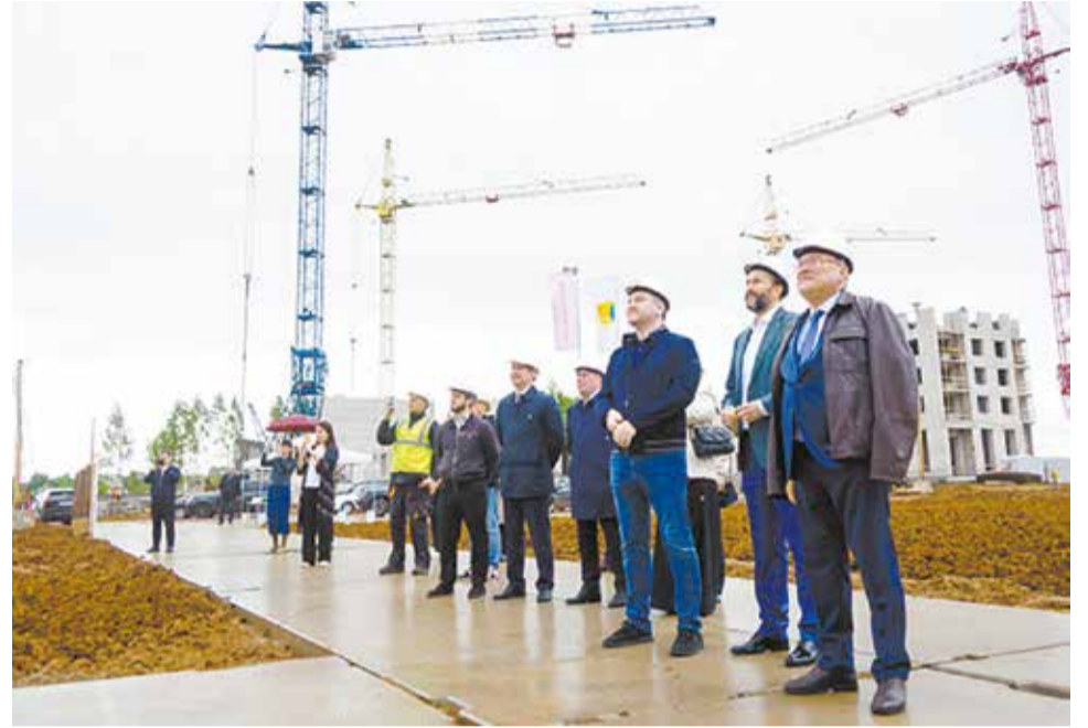
На стройплощадке – Александр Соколов и Андрей Березин.
