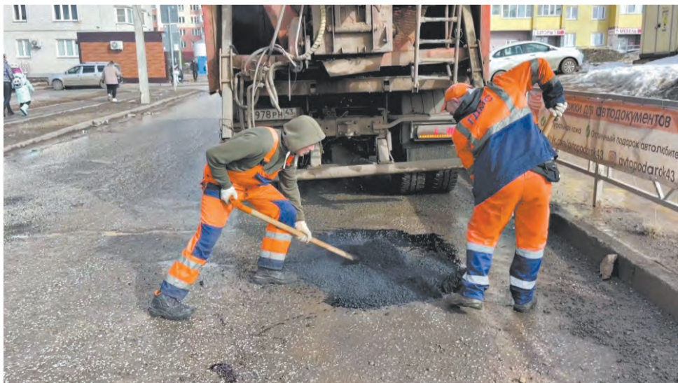
Дефекты на дорогах выравнивают литым асфальтом.
