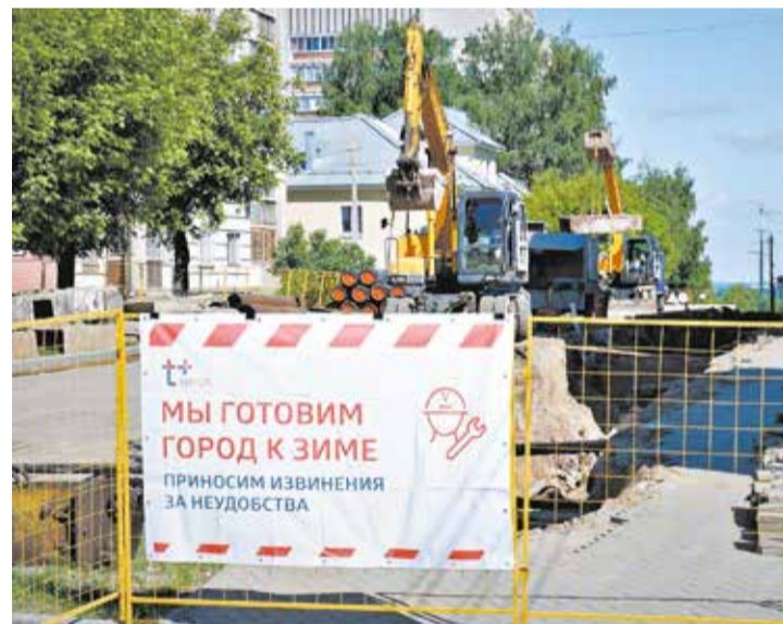
На Казанской развернулись работы по замене трубопровода.
