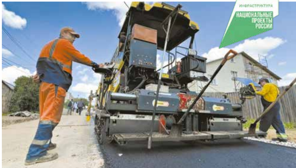
На улице Крупской работы возобновлены после ремонта теплотрассы. Фото киров.рф
