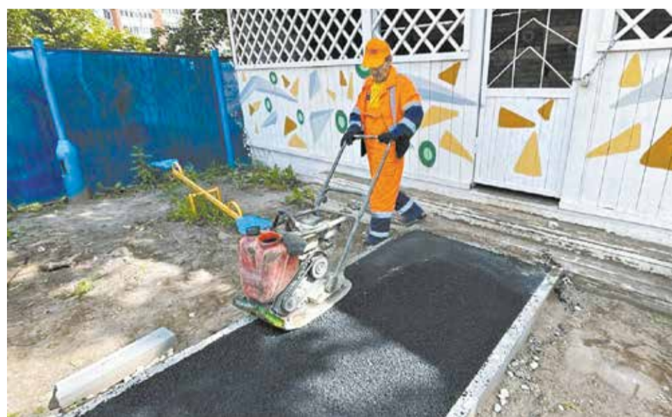
В детских садах ремонтируют проезды, тротуары и дорожки к верандам. Фото киров.рф
